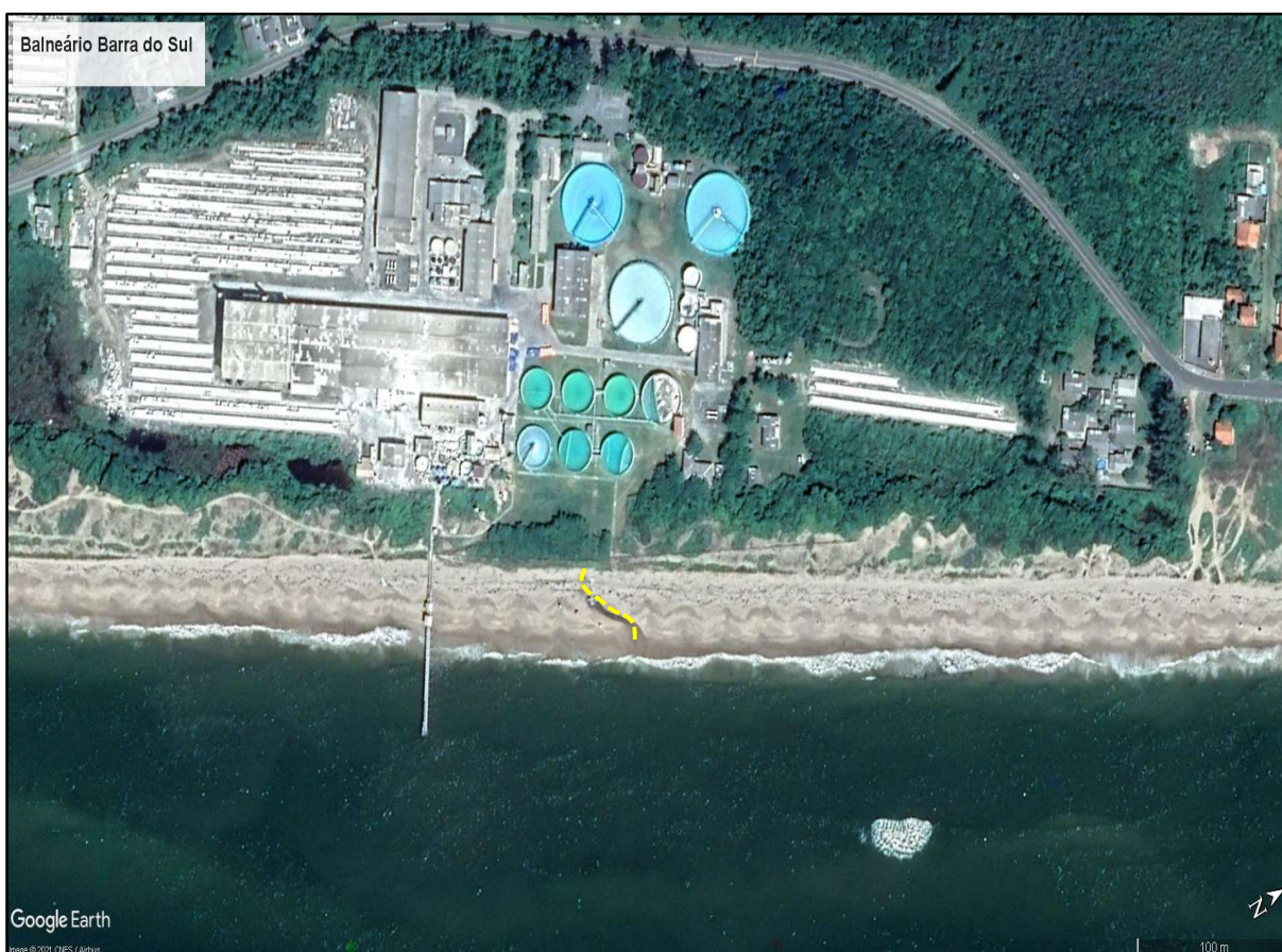
Figura 43. Sangradouro 260 localizado na praia Barra do Sul Central no município de Balneário Barra do Sul. Fonte: Imagem de satélite extraída do Google Earth de 02/2019.
