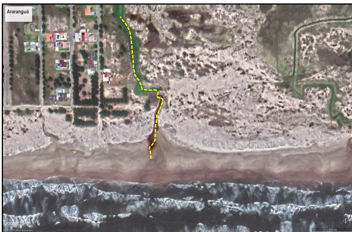
Figura 19. Sangradouro 072 localizado na praia Paiquerê Sul no município de Araranguá. Fonte: Imagem de satélite extraída do Google Earth de 12/2018.
